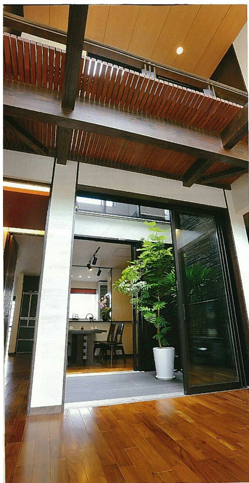
空中廊下のある吹き抜けのリビング。構造梁一本一本まで構造計算し、無駄な壁や木材・金物は一切ないので、コストダウンにつながる
