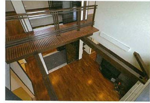
2階中央の廊下は、格子張りとして1階との連続性をもたせた。
