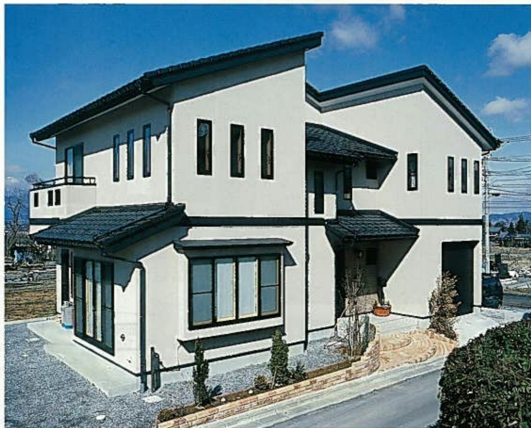
南北に細長い敷地を有効利用するため、1階に車庫をビルトイン。左右対称の片流れ屋根を玄関中央で分離した独特のスタイルが印象的なモダン住宅。 基礎：鉄筋コンクリートベタ基礎モルタル塗り仕上げ、外壁：アクリルリシン吹付、屋根：カラー鉄板葺
