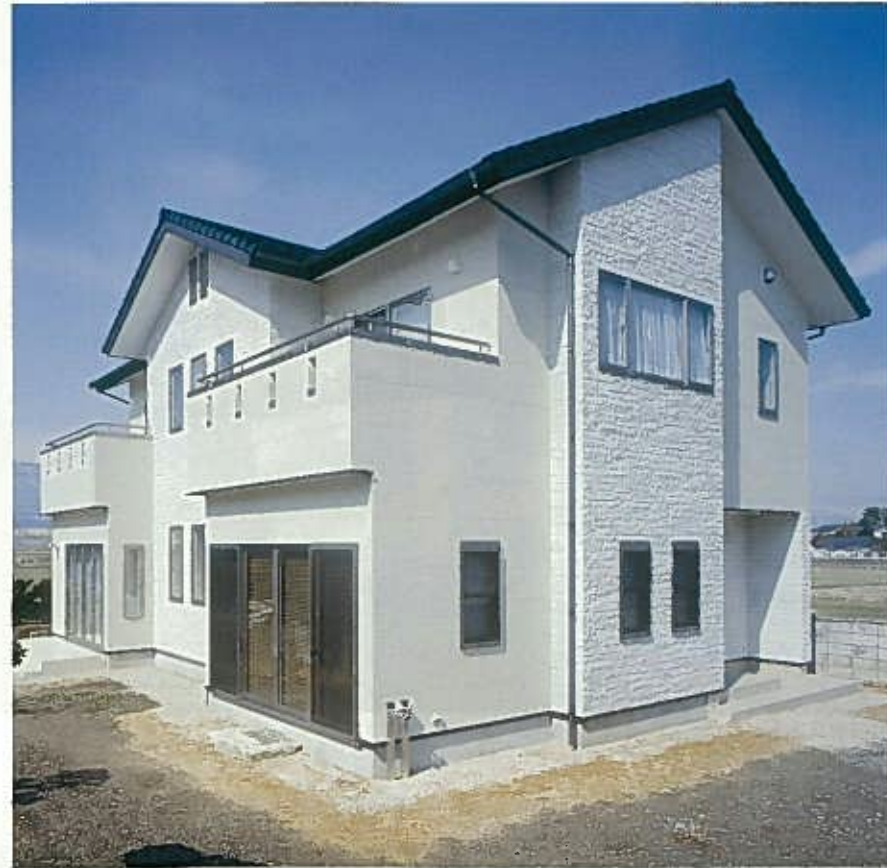
上品で落ち着いた白壁に左右対称のデザインが美しい。南面のファサードはリビング部分をセットバック。構造材には防虫加工をして使えるヒバ4寸角を使って高耐久のつくり。
