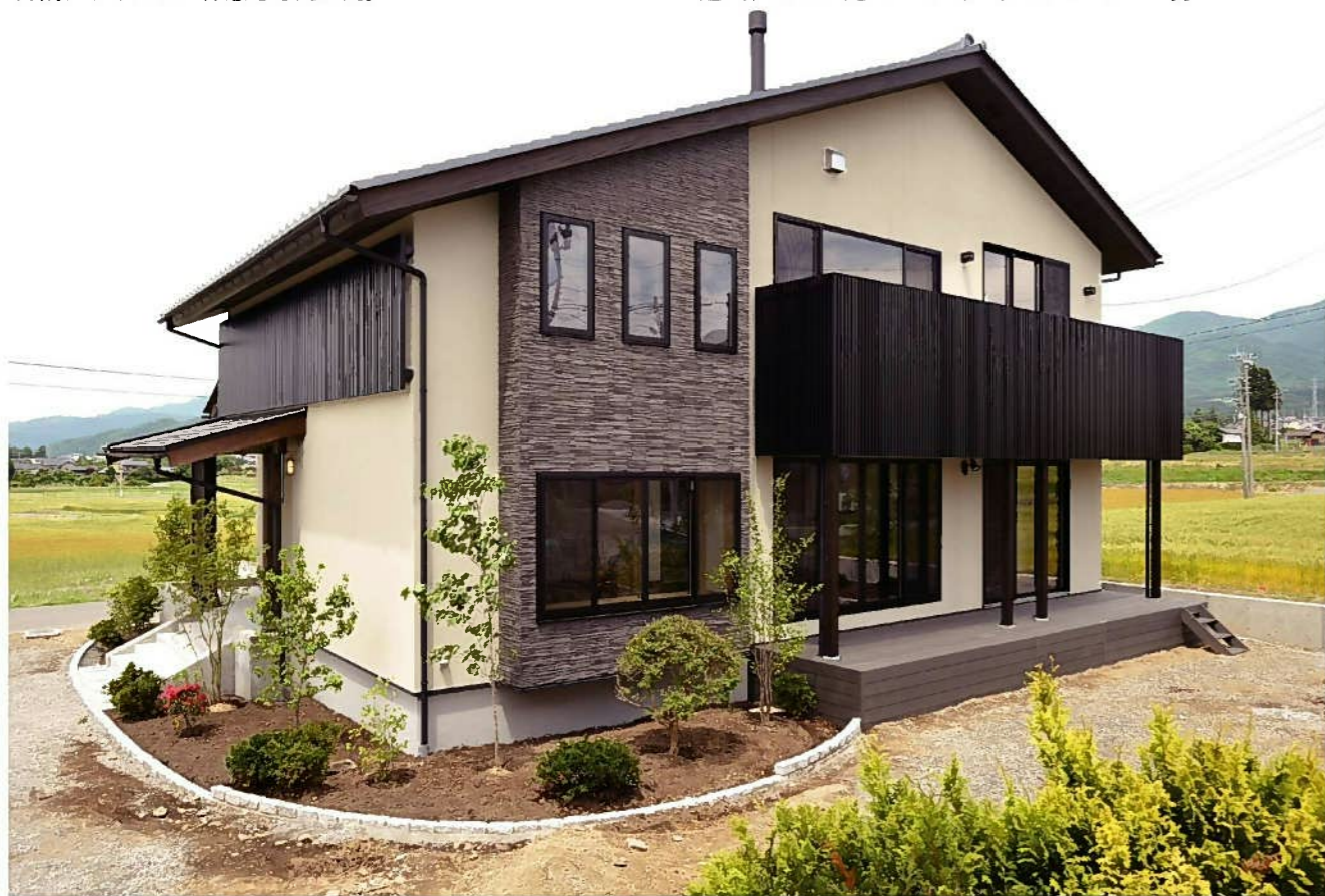
上/西向きの玄関ポーチには格子の目隠しを配置。2階部分の格子は、民芸調を漂わすデザインであると同時に西日を遮蔽する役割も果たす。床下点検のため基礎高を高くしたことが、玄関に風格をもたらしている。 下/大屋根のどっしりとした外観は周囲の田園風景とも、よく調和する。南側ベランダにも格子の目隠しを設け、外観デザインに一体感をもたせた。
