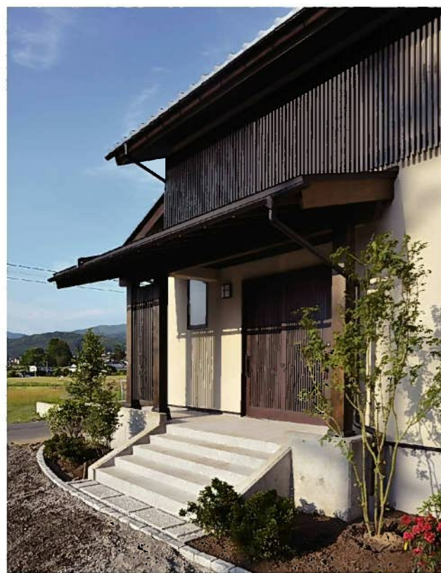
上/西向きの玄関ポーチには格子の目隠しを配置。2階部分の格子は、民芸調を漂わすデザインであると同時に西日を遮蔽する役割も果たす。床下点検のため基礎高を高くしたことが、玄関に風格をもたらしている。 下/大屋根のどっしりとした外観は周囲の田園風景とも、よく調和する。南側ベランダにも格子の目隠しを設け、外観デザインに一体感をもたせた。
