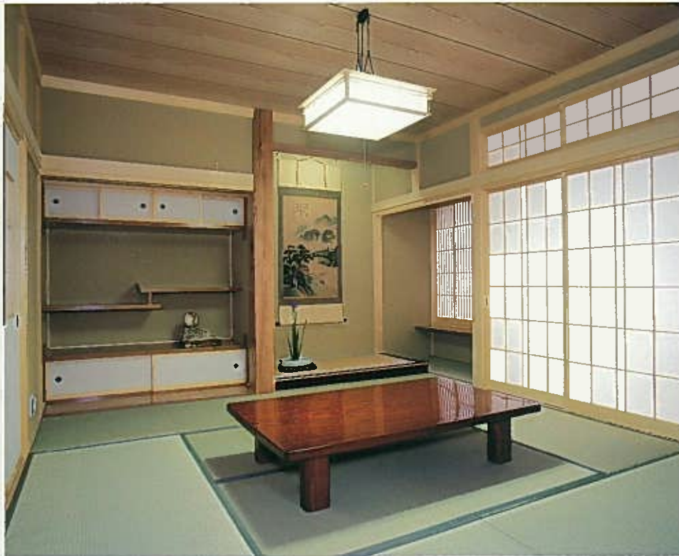
和室 中廊下北側の奥座敷。床柱は6寸角の日光杉。床框はケヤキ、落とし掛けは杉。一畳の書院の間をしつらえた本格的な格式の床の間。床脇には天袋と地袋の間に簞返しのある連棚を設けた。
