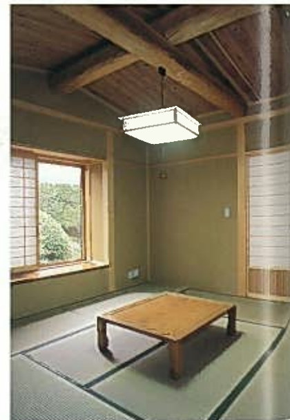
和室 南東側の和室8畳。力強い磨き梁は自己所有林から切り出した松丸太。
