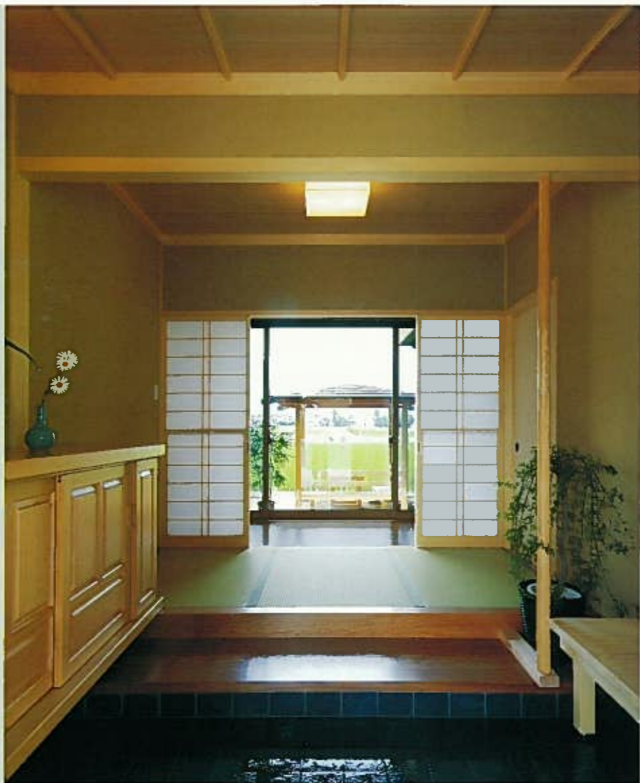
ジュラク塗り壁に杉一枚目張り天井とした気品ただよう仕上げ。ゆとりある玄関には、ひと休みできる手すり付きの腰掛待合を。(T邸)
