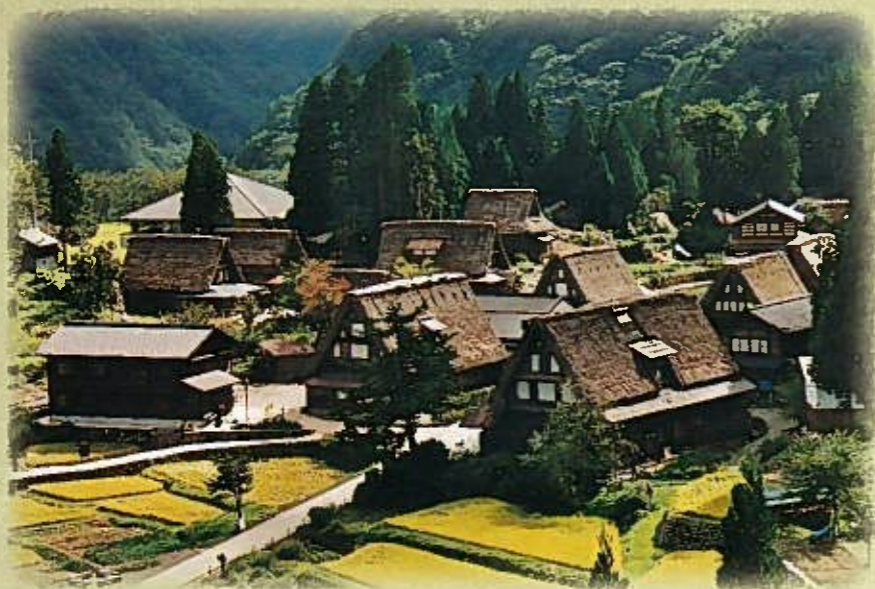
歴史の中では、日本の住宅はストックとして受け継がれてきたが。(富山県・五箇山)
