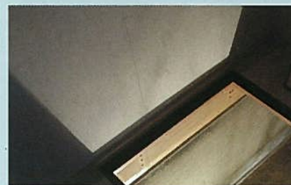
超長期住宅では床下を高くしメンテナンスがしやすい
